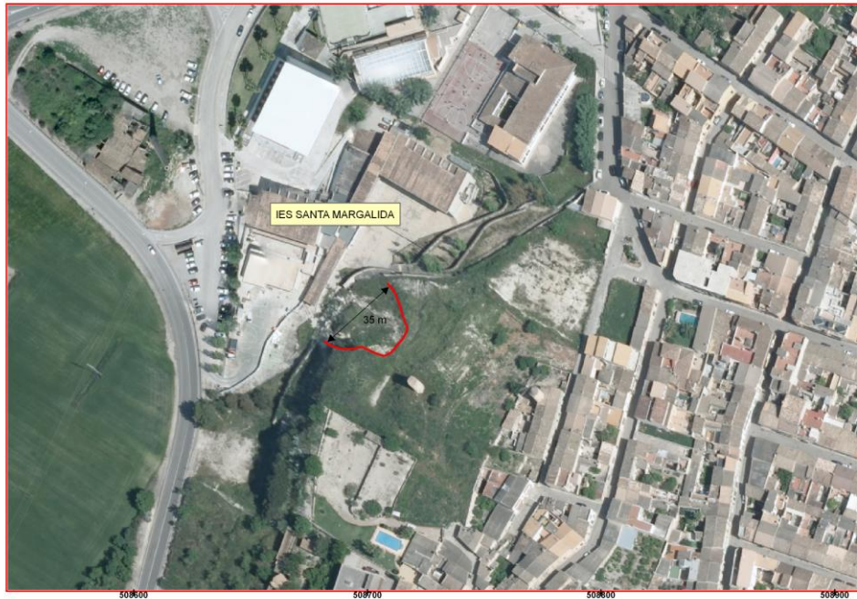
FIGURA 2.- Detalle de la cicatriz de los dos deslizamientos de la figura 3 y situación del IES Santa Margalida en el borde nororiental del núcleo urbano, sobre la foto aérea del 2012
